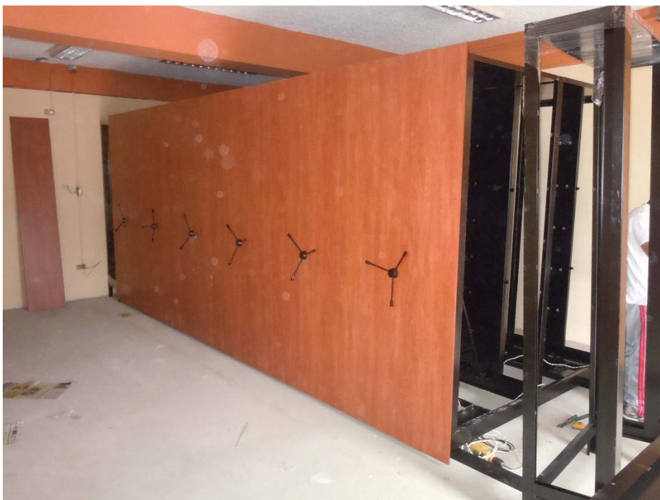
Implementación del sistema de rodarchivos en el espacio destinado al Archivo Institucional – 2013.
