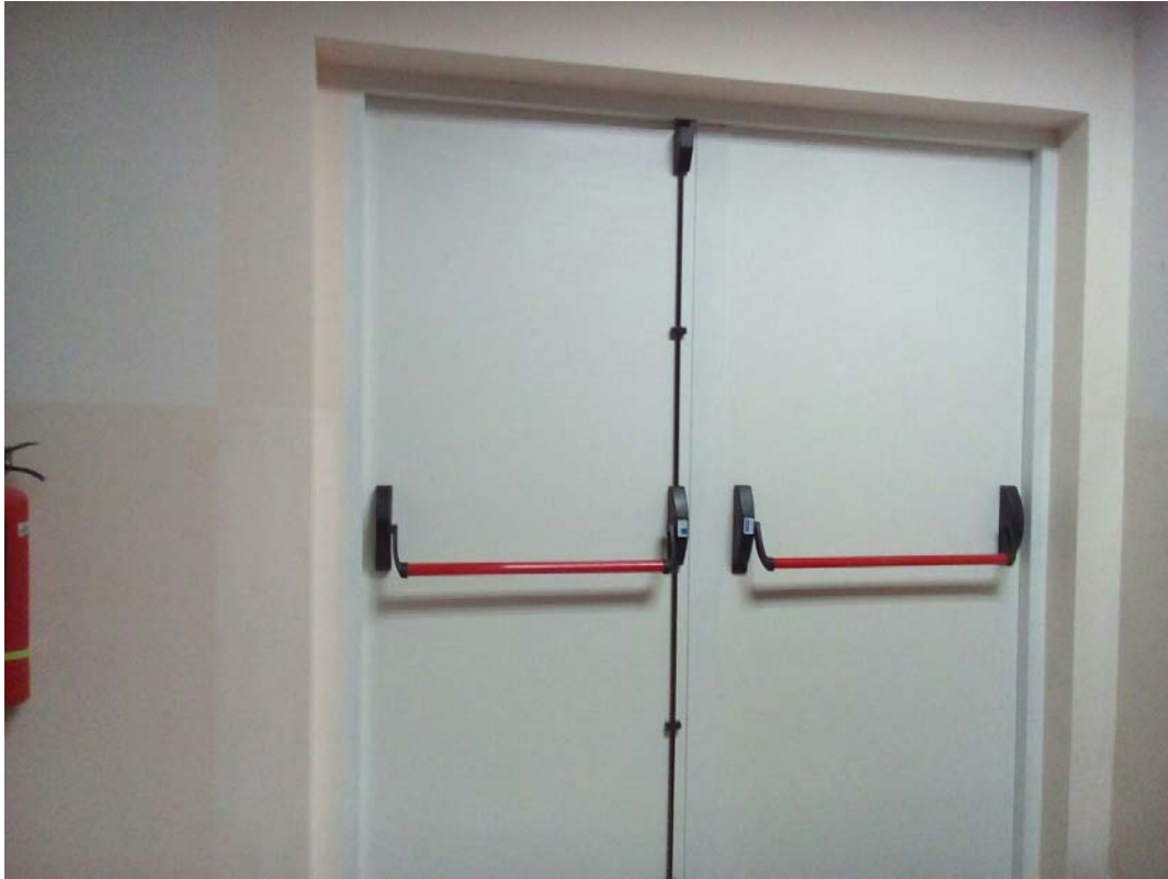
Instalación puerta corta fuegos para mayor seguridad de la Zona de Conservación. 13/12/2017
