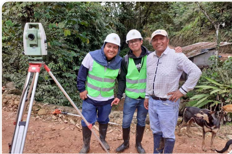
Estudiantes de Ingeniería Civil, Mecánica y Electricidad diseñaron y construyeron una red de agua potable que beneficiará a 280 familias de la comunidad San Vicente de Andoas, cantón Pedro Vicente Maldonado.
